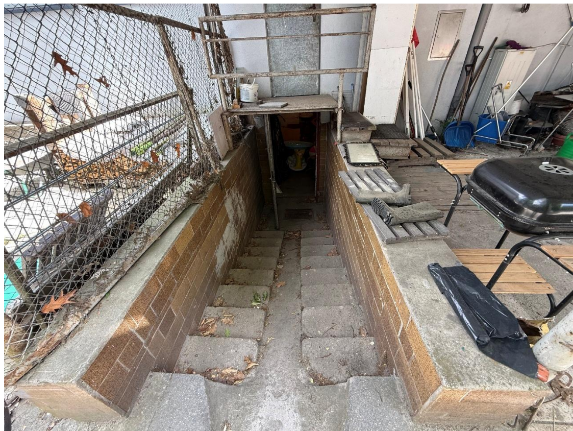
ZDJĘCIE 9: WIDOK NA ZSYP OPAŁU ZABEZPIECZONY DESKAMI
