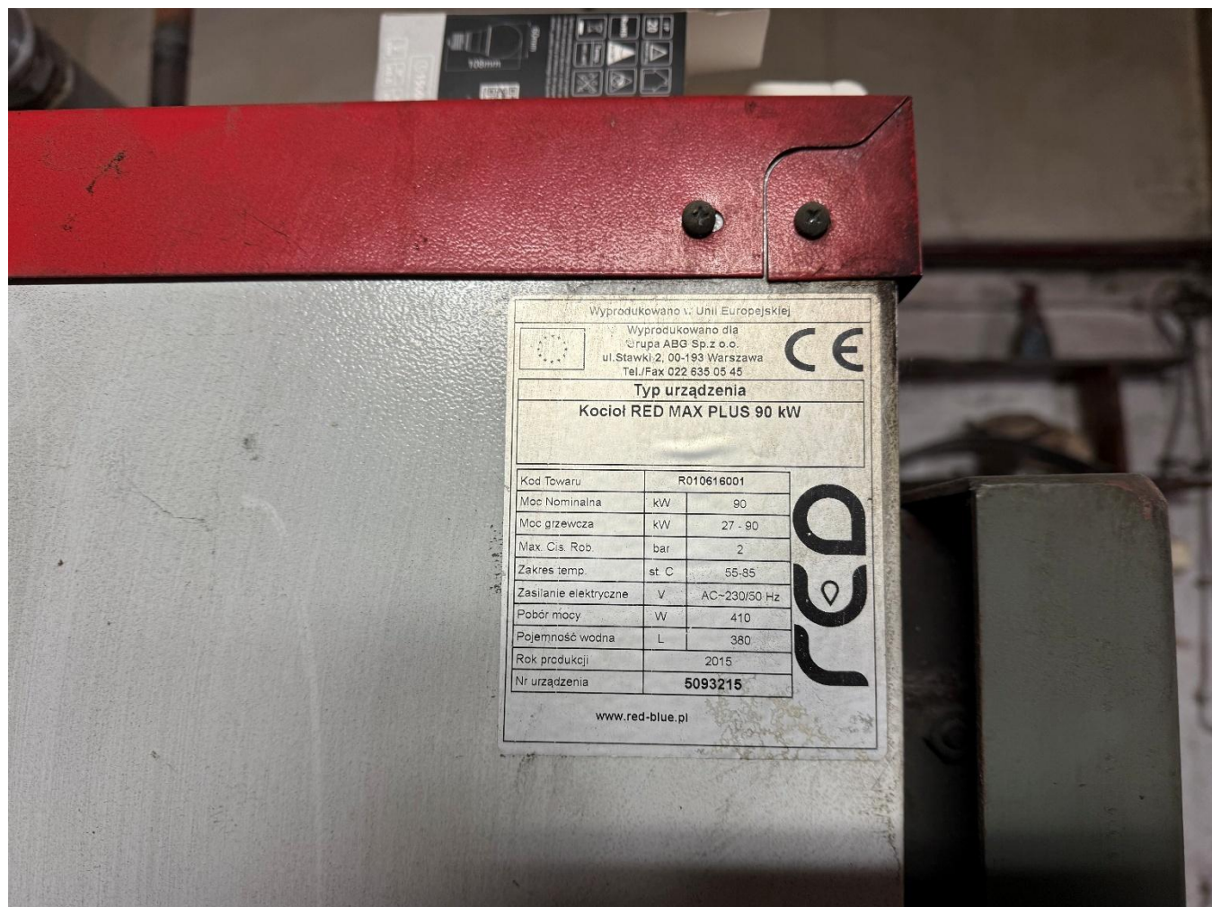
ZDJĘCIE 12: TABLICZKA ZNAMIONOWA KOTŁA DO DEMONTAŻU
